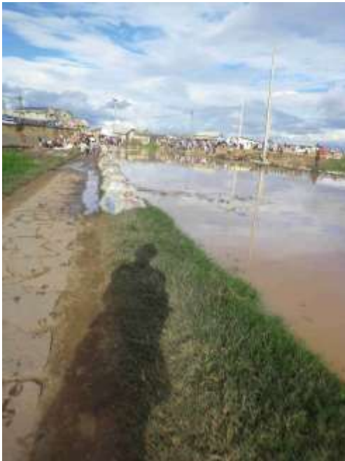
Les sacs de sable le long du sentier
