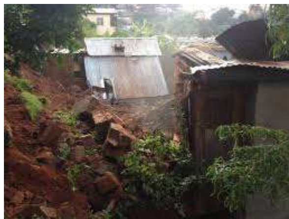
Eboulement d'une maison
