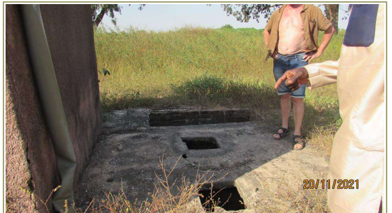
La fosse septique
