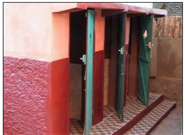
Après les travaux
